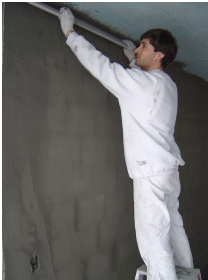
Verarbeitung von Kalk-Zement-Unterputzen.
