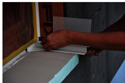
RÖFIX Sol Pad mit RÖFIX MS Polymer Dicht und Klebmasse einkleben
