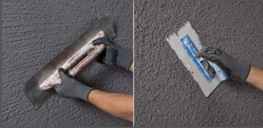
RÖFIX SiSi-Putz® VITAL aufziehen und strukturieren
