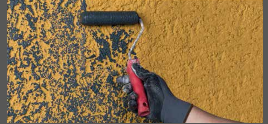
Grober Strukturdeckputz mit geglätteten/verdichteten Spitzen in einer zweiten Farbe überstrichen
