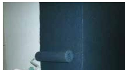
Der Endauftrag mit der RÖFIX PE 519 PREMIUM DARK Fassadenfarbe erfolgt satt, gleichmässig deckend und mittels geeigneter Gerätschaft nach mindestens 24 Stunden Standzeit bei Normalbedingungen (20 °C Untergrund-/Lufttemperatur und 65 % relativer Luftfeuchte).
