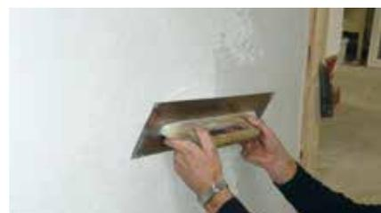
Der Grundanstrich mit der RÖFIX PE 519 PREMIUM DARK Fassadenfarbe (nach werkseitig eingetöntem Farbton) erfolgt satt, gleichmässig deckend und mittels geeignetem Arbeitsgerät.
