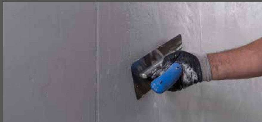
Eine weitere Schicht RÖFIX Anticofino® aufziehen
