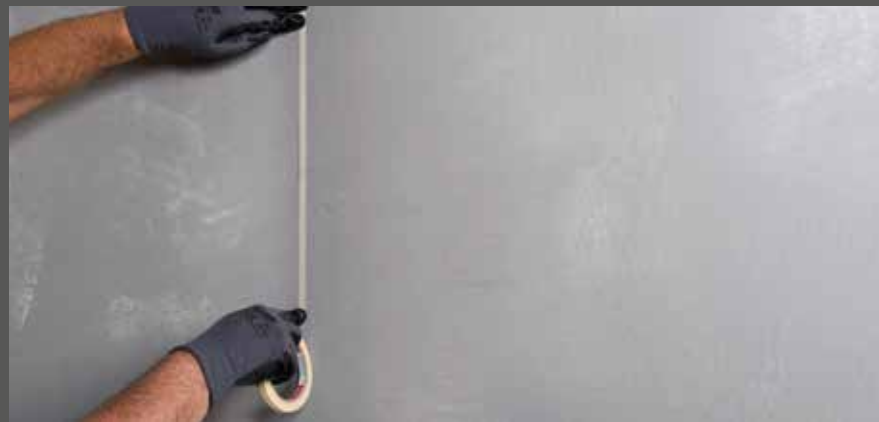
Klebeband einlegen
