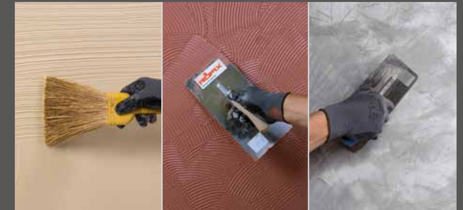
RÖFIX Decofino mit Besen strukturieren
