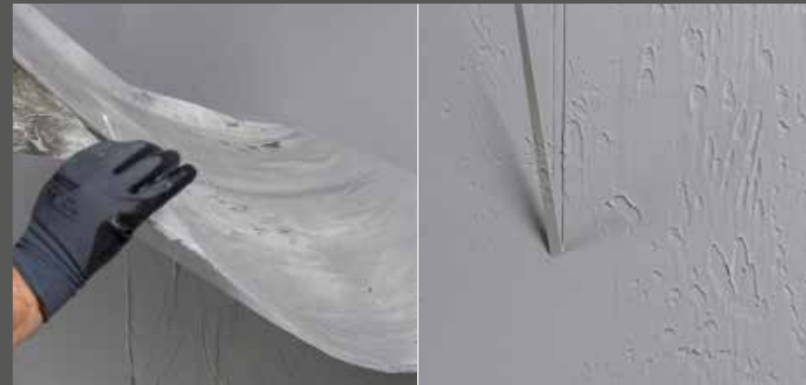
Die Nylonfolie abnehmen und das Klebeband entfernen
