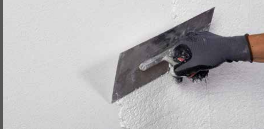
Grundieren und Oberputz vorlegen
