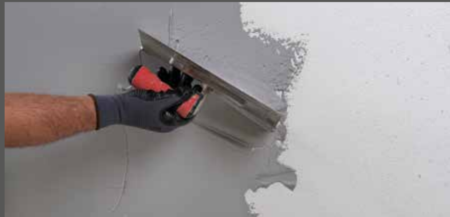
RÖFIX Anticofino® aufziehen und scharf abziehen
