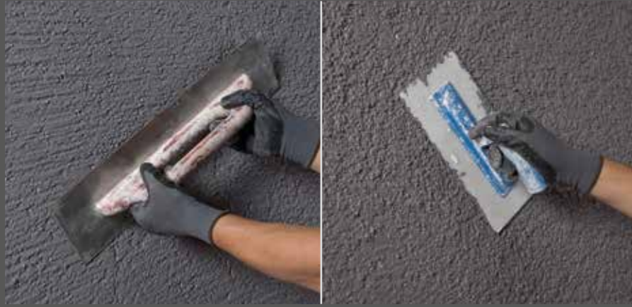
RÖFIX SiSi-Putz® VITAL aufziehen und strukturieren
