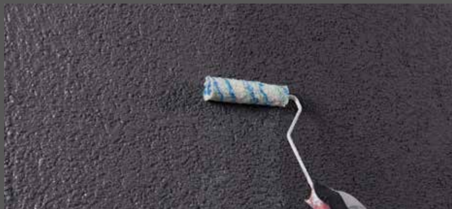
Eingefärbter RÖFIX Struktur-Deckputz wird mit RÖFIX PP 403 MULTI Silikonharz-Lasur mit RÖFIX COLORGLOW oder mit RÖFIX SILVERGLOW überstreichen
